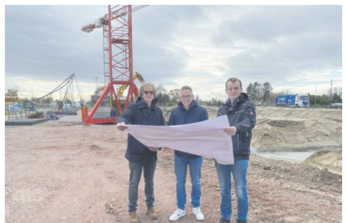
v.l.n.r.: Michael Thoma (Europa-Park), Kai-Achim Klare (Bürgermeister) und Tobias Decoux (EP-Bauleitung) vor der Baugrube für das Parkhaus am Tipi-Dorf.
